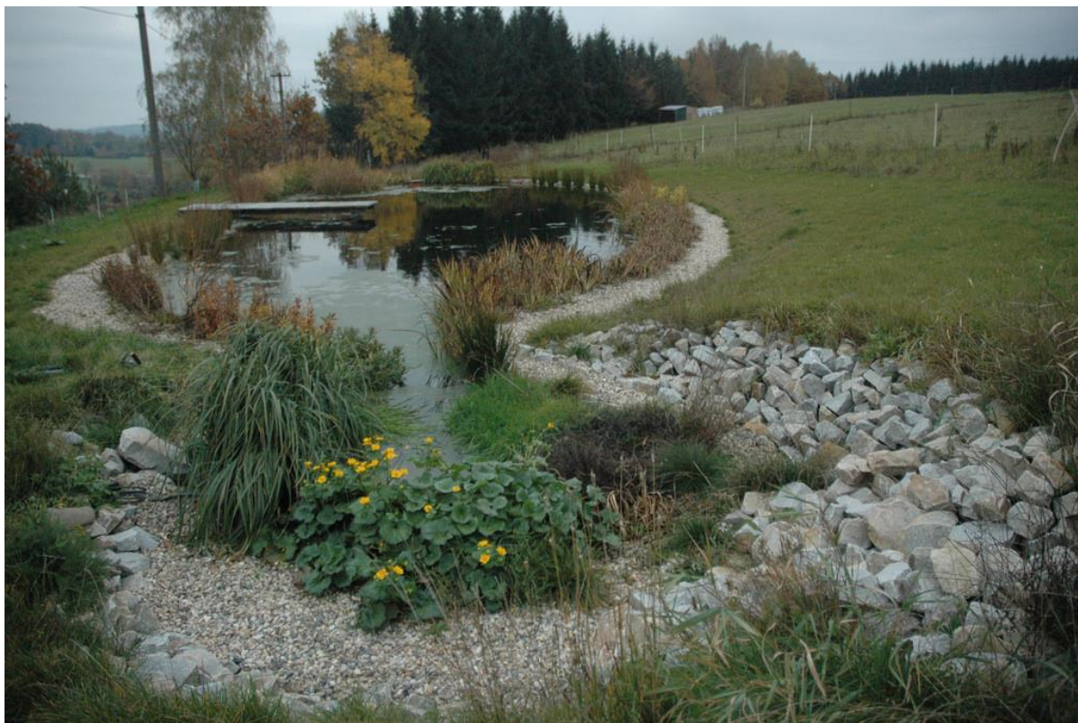
Obrázek 28 Vegetační čistírna odpadních vod. (Foto: Kořenovky.cz)
