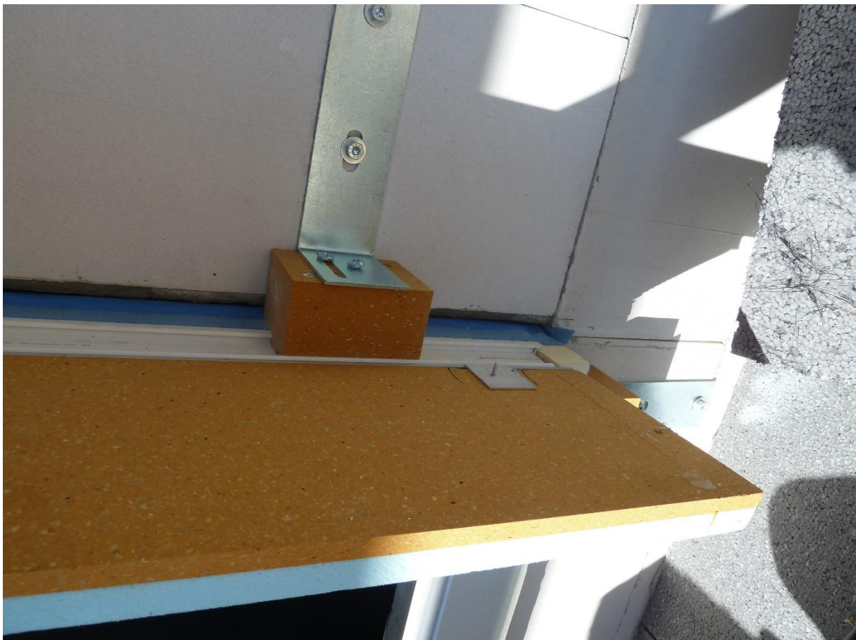
Obrázek 11 První krok předsazené montáže. (zdroj: PORSENNÁ o.p.s.)
