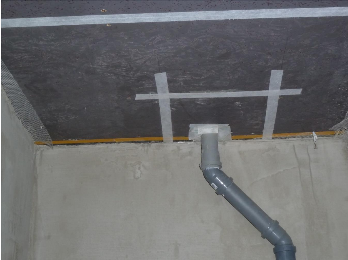
Obrázek 11 První krok předsazené montáže. (zdroj: PORSENNÁ o.p.s.)
