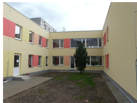
Foto: ZŠ Angel (Mladenovova), Praha 12. Realizace v téměř pasivním standardu podpořená z OPŽP. K pasivnímu standardu chybí „pouze“ nucené větrání s rekuperací. V novém programovém období bude toto opatření součástí uvažovaných nákladů.
